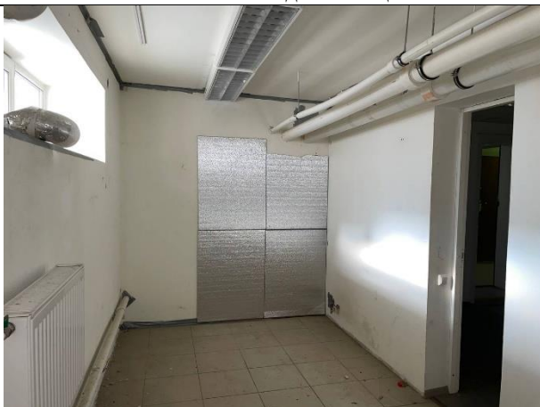
Фото № 19 – Внутреннее состояние помещения
