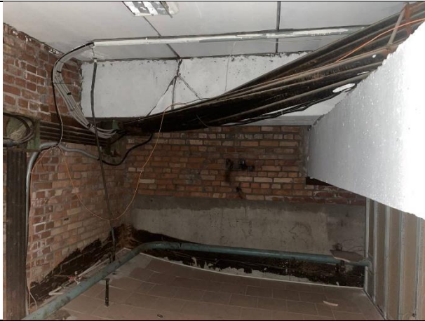
Фото № 29 – Внутреннее состояние помещения
