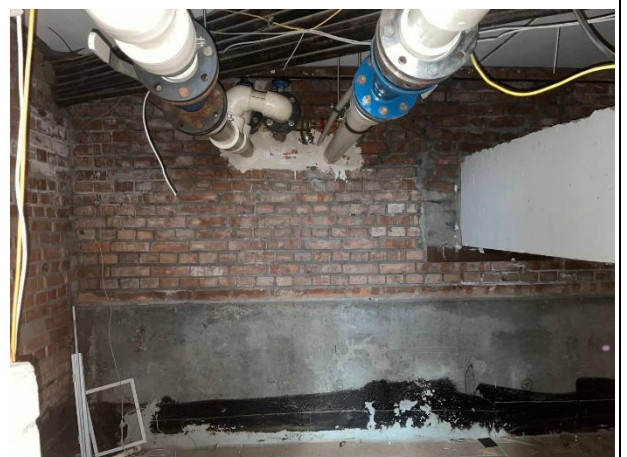
Фото № 28 – Внутреннее состояние помещения
