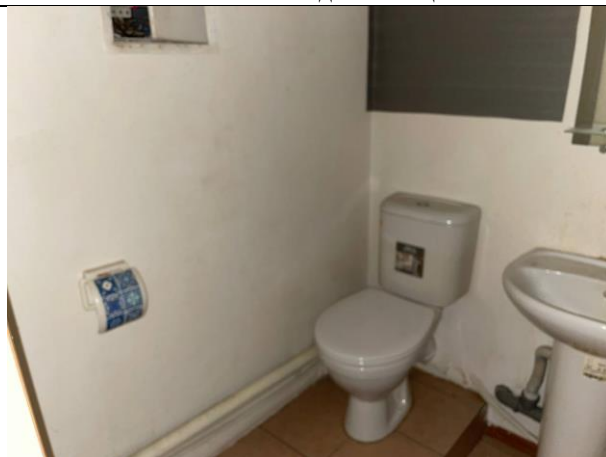
Фото № 20 – Внутреннее состояние помещения
