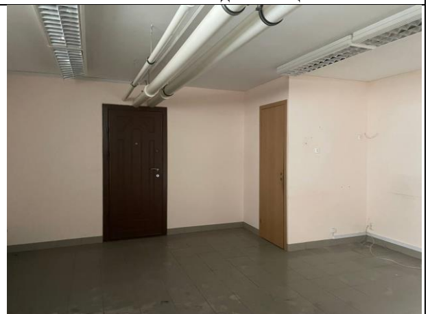
Фото № 26 – Внутреннее состояние помещения
