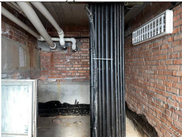
Фото № 35 – Внутреннее состояние помещения
