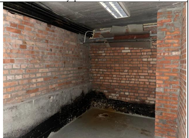
Фото № 36 – Внутреннее состояние помещения
