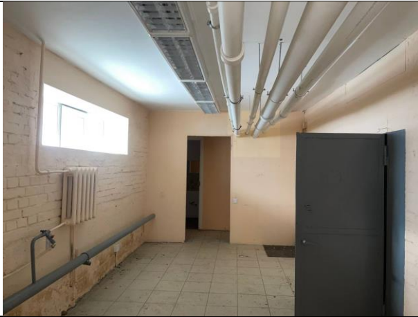
Фото № 37 – Внутреннее состояние помещения
