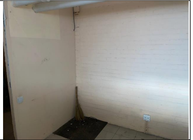
Фото № 38 – Внутреннее состояние помещения
