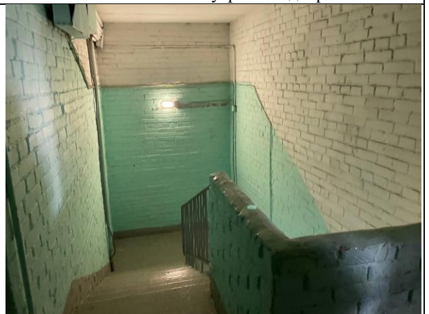
Фото № 10 – Лестничная клетка
