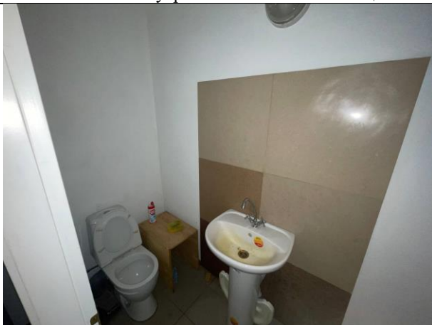
Фото № 15 – Внутреннее состояние помещения
