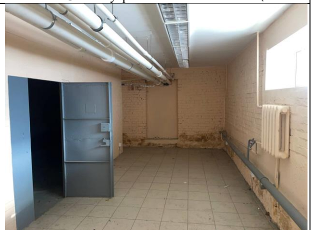
Фото № 34 – Внутреннее состояние помещения
