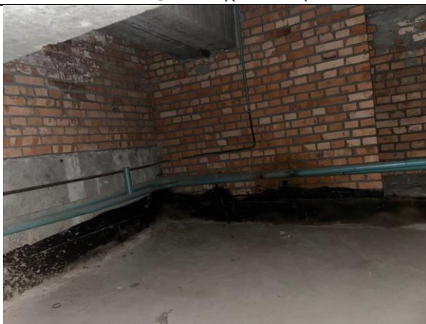
Фото № 33 – Внутреннее состояние помещения
