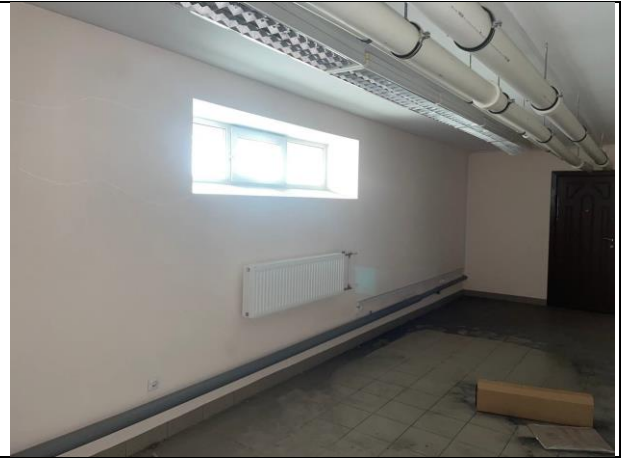
Фото № 30 – Внутреннее состояние помещения
