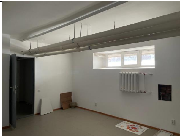
Фото № 14 – Внутреннее состояние помещения
