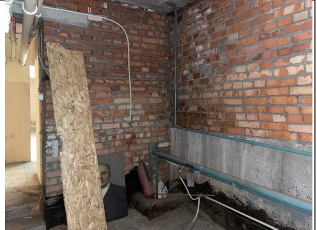
Фото № 32 – Внутреннее состояние помещения
