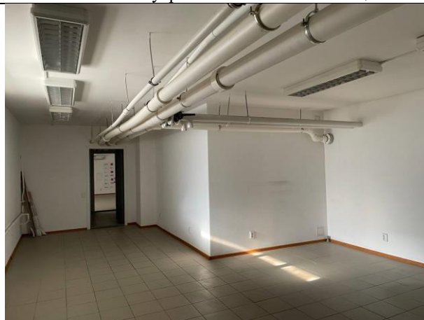
Фото № 16 – Внутреннее состояние помещения
